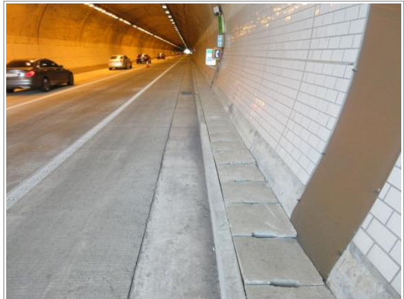
터널 공동구 전경
