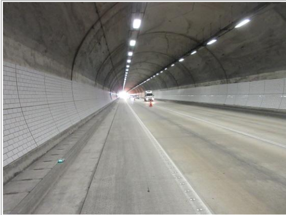
터널 내부 전경
