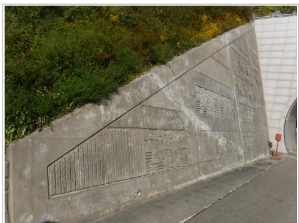
시점측 옹벽 전경
