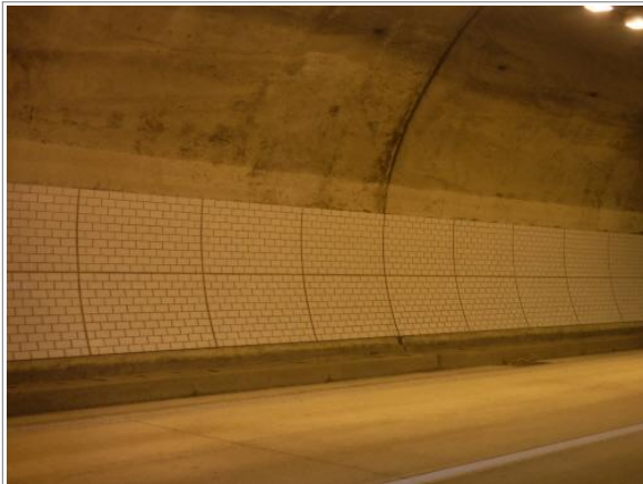
측벽부 타일마감 전경
